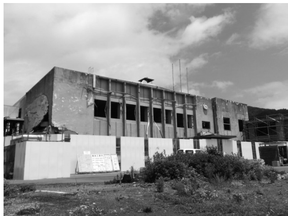
被災した大槌町役場。町長が変わり、震災遺構としての存続が危ぶまれている。
