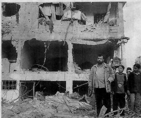
ガザ市で16日、イスラエルの攻撃で壊された建物A.P
